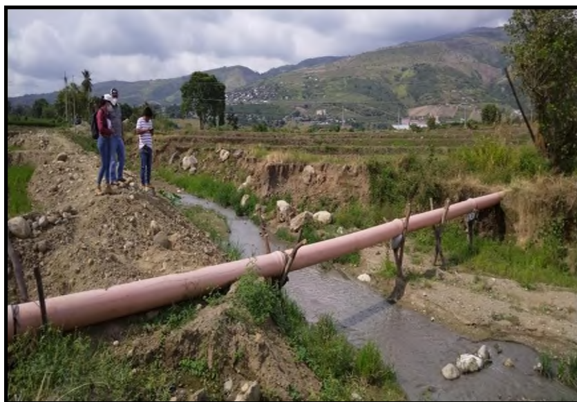
Fotografía N° 02: Destrucción del canal Vilchez por la quebrada Fila Alta.
