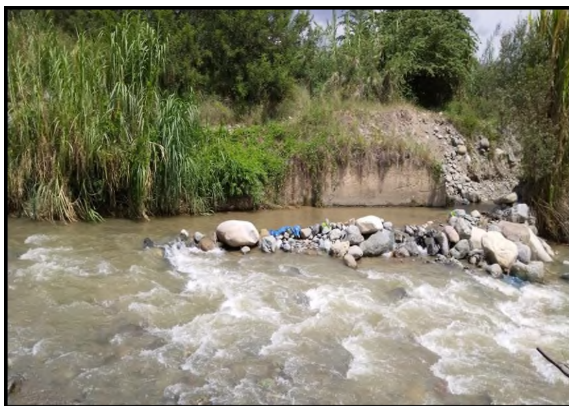
Fotografía N° 04: Destrucción y colmatado del cauce en la Bocatoma Canal Las Balsas.
